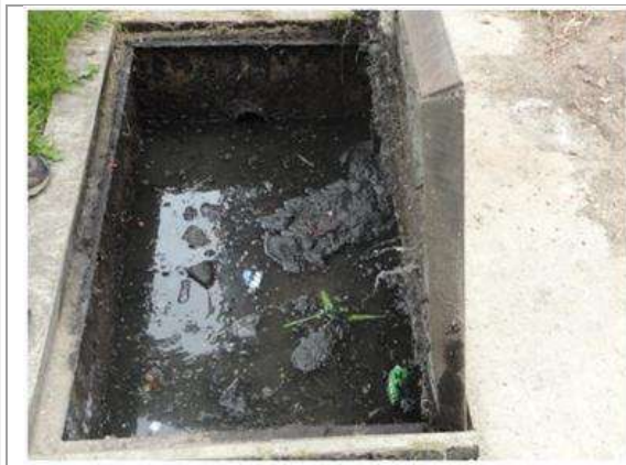
Foto No. 3 pozo séptico previo a la descarga acequia CI 194
