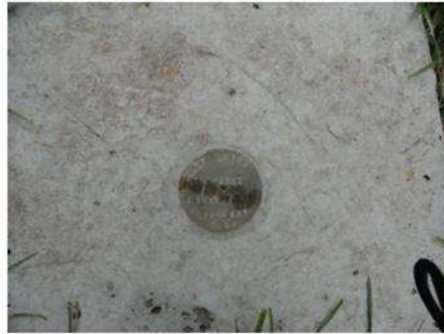
Foto No. 11 – Placa de nivelación (la misma placa que la del pz-11-0148)
