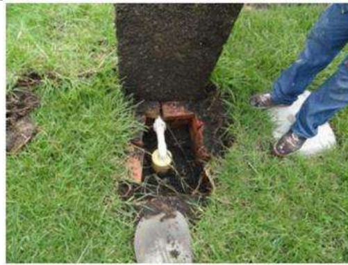
Foto No. 13- Tubería de producción de la perforación
